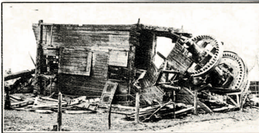
De houten reus van Denderhautem, een dier wegstervende windmolens op het Vlaamsche land, is vorige week door een rukwind van zijn voetstuk gestooten.
