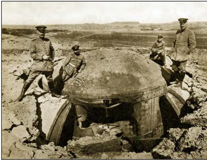
Duitsers bij een kapot geschoten 12cm dikke betonnen koepel
