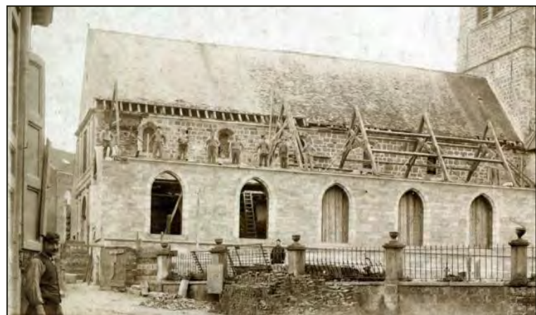
Pastoor Van de Putte poseert voor de nieuwe extra zijbeuk terwijl werklui de gebinten plaatsen van het dak.
