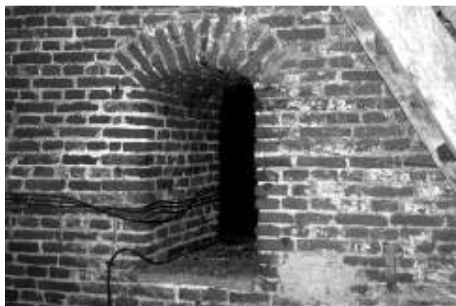
Metselwerk binnenzijde kerktoren
