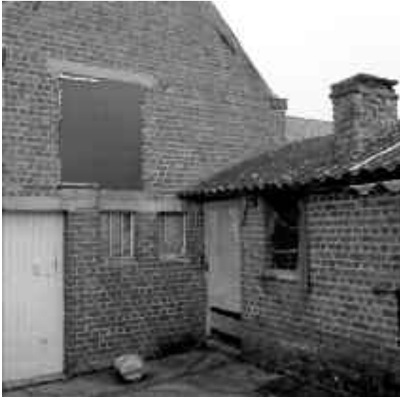
Hoeve Van Eeckhout, Dwarsstraat met intacte bakoven
