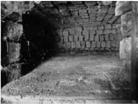
Hoeve Van Eeckhout, Dwarsstraat binnenzicht bakoven
