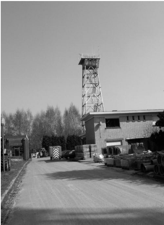
Kleine mast van 25 meter hoogte met administratief gebouw
