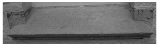
De witsteen die terug werd blootgelegd. Dit toont dat er nu een grondige restauratie is gebeurd.
