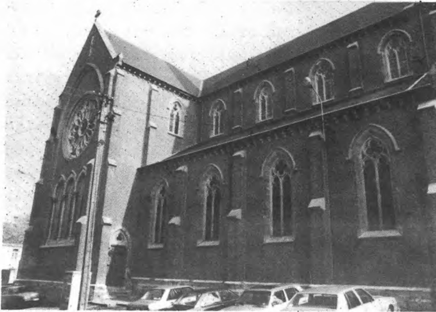
Zicht op de zijgevel
